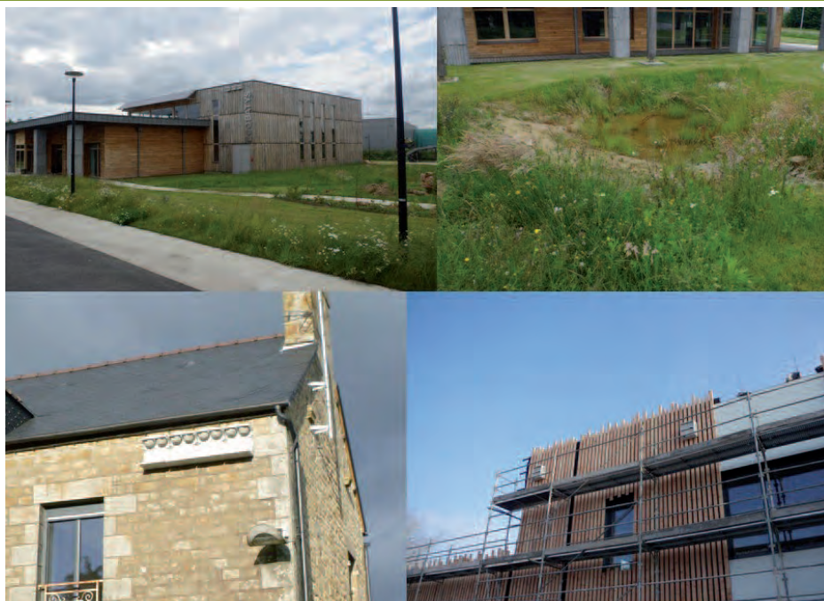
Les aménagements urbains favorables à la biodiversité permettent une nouvelle dynamique écologique autour des bâtiments neufs ou réhabilités.
