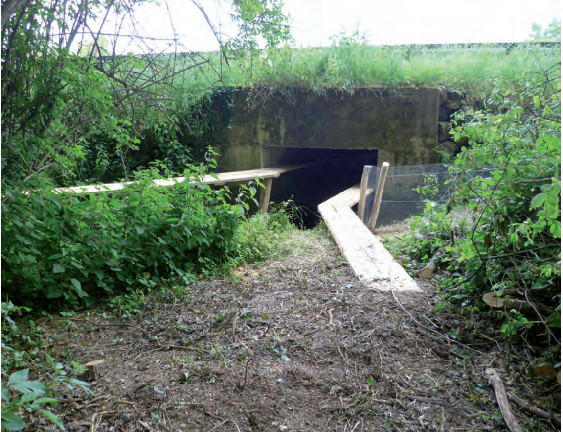
Passage à faune sous la RD82 à Melesse - Passage inférieur dans un pont cadre où passe le ruisseau du Quincampoix.
