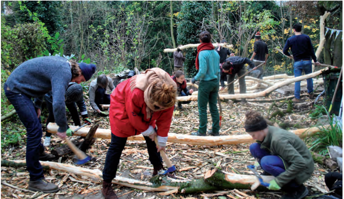
Des bénévoles participent à un chantier d'écorçage de robiniers, érables et peupliers locaux pour la construction de la matériau-thèque.
