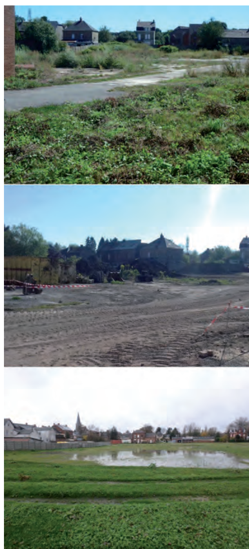
Évolution de la friche Miroux avant la deuxième phase de démolition, pendant et après les travaux en 2017.
