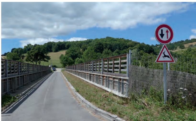
Banquette enherbée sur pont routier.
