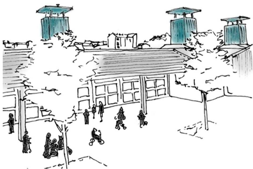
Illustration n° 11 : les cheminées de ventilation du groupe scolaire des Boutours 2 à Rosny-sous-Bois, un exemple de frugalité technique
